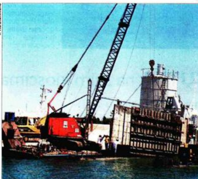
U tijeku je postavljanje metalne oplata
